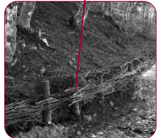
Fascines, branches de saules tressées sur des poteaux
